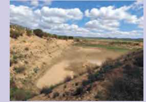
El mal estado de los taludes, balsas o rotondas es una imagen muy habitual.
